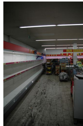
prévoir le matériel (ici : démontage)
