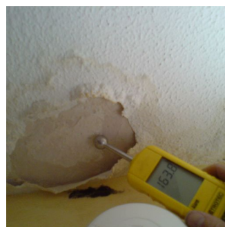
mesure de l'humidité d'un mur
