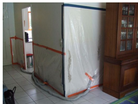
assèchement de cloisons
